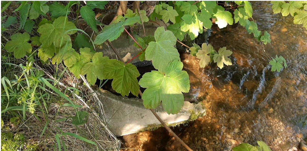
Abbildung 2: Ablaufrohr im Hühnerbach
